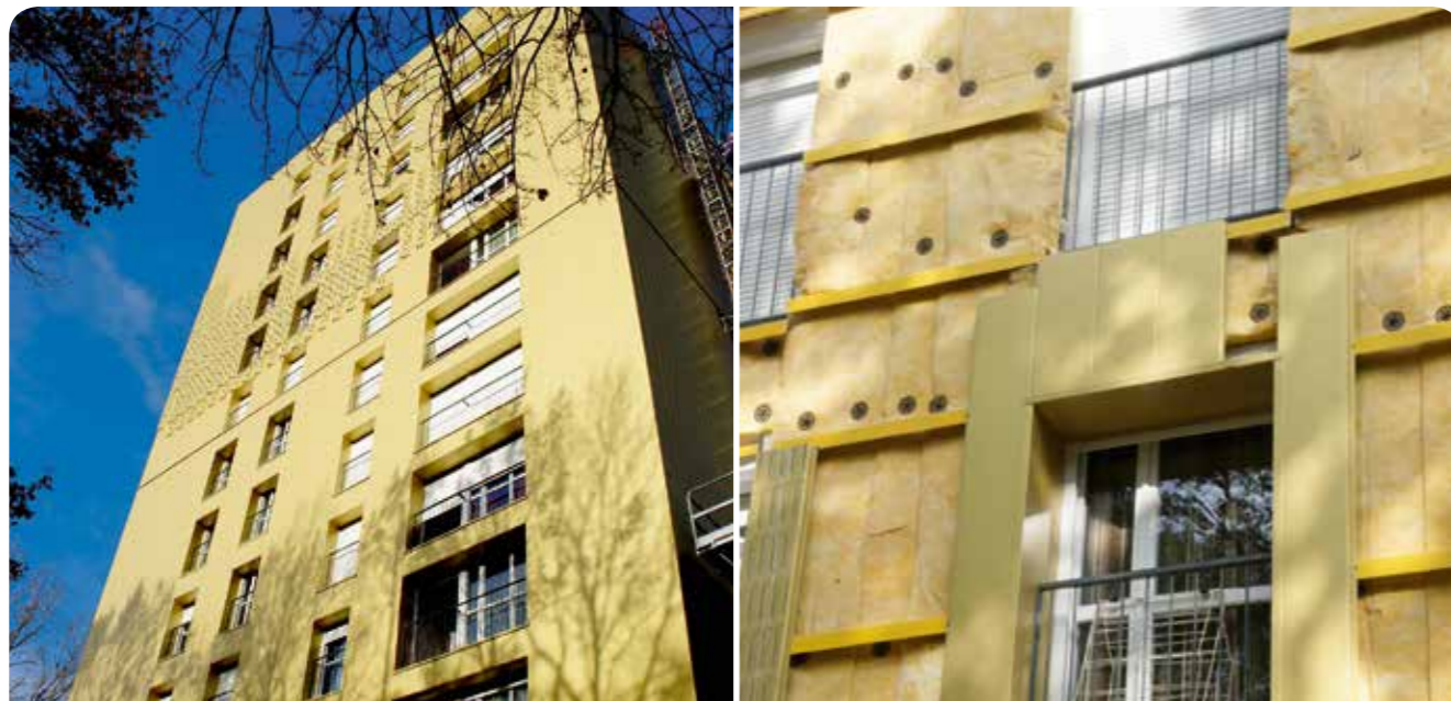
Sechs Hochhäuser „Herriot et Suisse“ | Le Mans | Frankreich | Nomade Architectes | Inter-Plage | Produkt: Reynolux® Building 1,47 mm, 3 Sonderfarben: Champagner, Gold und Bronze mit 30% Glanz
